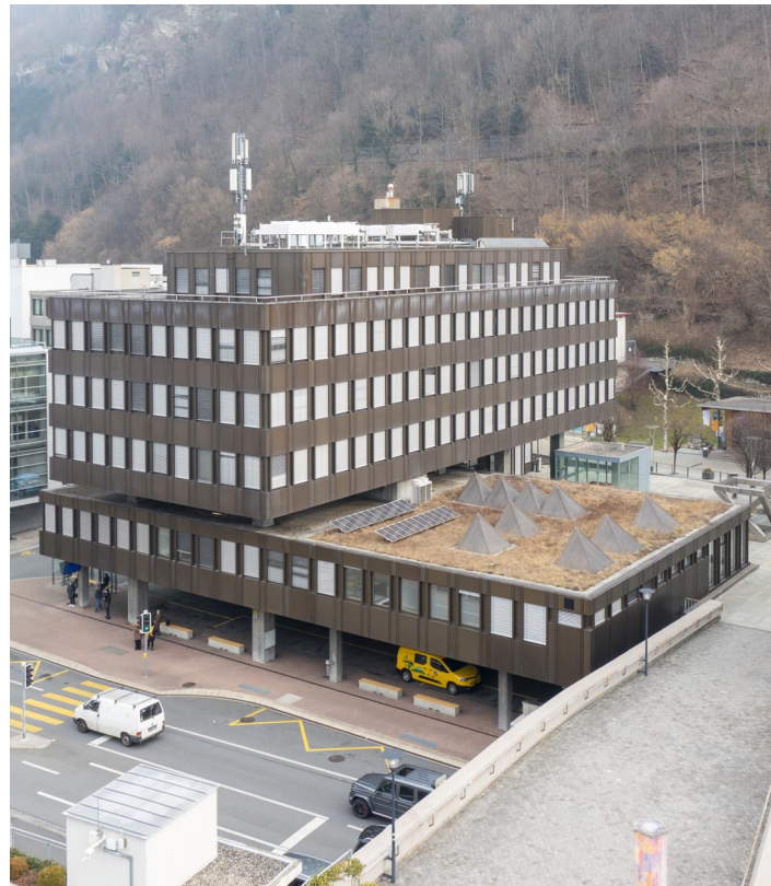
Verwaltungsgebäude in Vaduz: Bei einem Ja zur Initiative wäre der Umbau zur Landesbibliothek auf der Kippe gestanden. Bild: N. Vollmar
